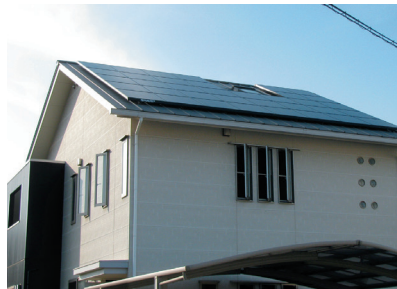
シャープ(株)製パネル 発電容量4.104kW
