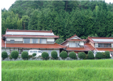
シャープ(株)製パネル 発電容量7.68kW
