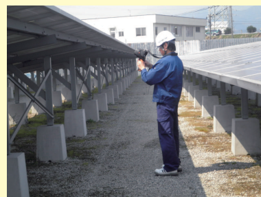
サーモグラフィー測定の様子
