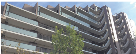
横浜市水道局様 モデル事業 (325件大規模マンションへ設置)
